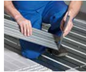
无需任何工具就可以简单调节导热板的长度
